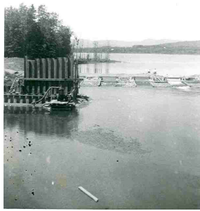
Barrage au lac Saint-Charles aménagé en 1913 et rehaussé en 1948. Photo C. Beaulieu Rousseau
